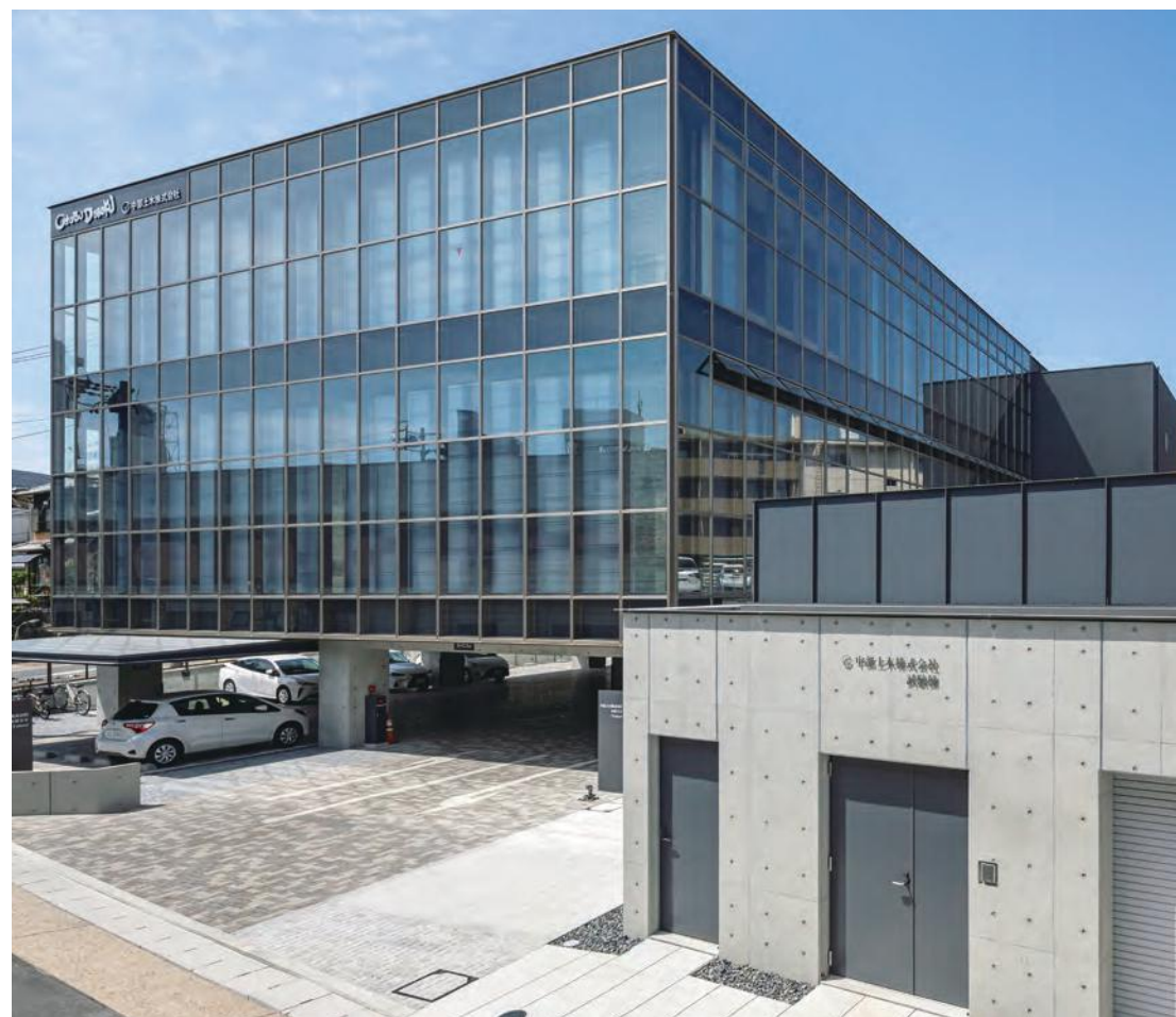
中部土木新社屋 |名古屋市名東区|
